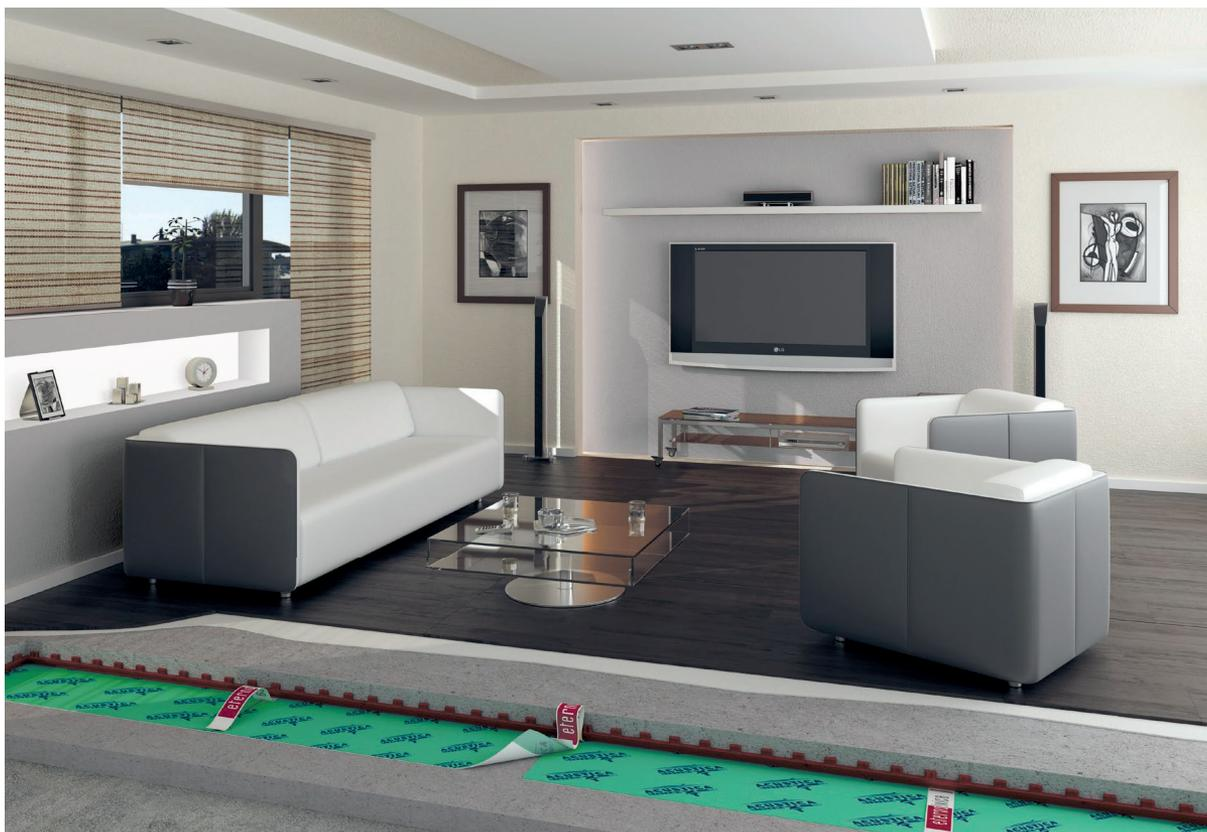
Utilizzo e inserimento dell'anticalpestio ECOTEX TXT. *Use and insertion of resilient underlay ECOTEX TXT.*
